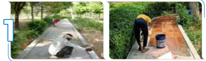
Base Preparation/ primer coating
